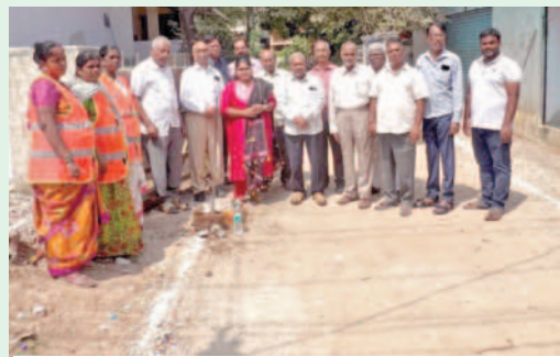
సీని రోడ్డు పనులు ప్రారంభిస్తున్న కార్పొరేటర్ శ్వేత మధుకర్‌రెడ్డి
